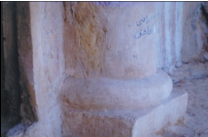
وینہی ۱۳: سہیری خوارہوہی کۆلہگہی لہ بہرد تاشراو و جۆری نہخشہکھی بکہ ئیستاش بہ ہمان شیوہ رەفتار دہکریت.
